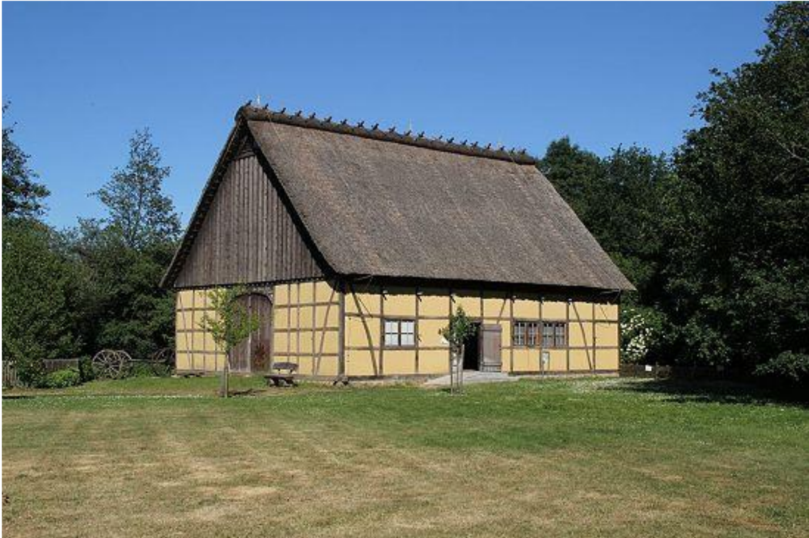
Erneuerung von Lehmputzwänden
