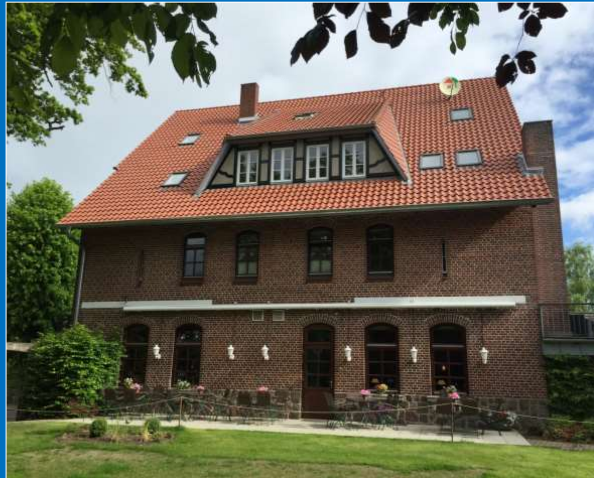
Dach- und Gaubenerneuerung mit DE-Förderung, hier: Gasthaus zum Lindenhof in Marxen
