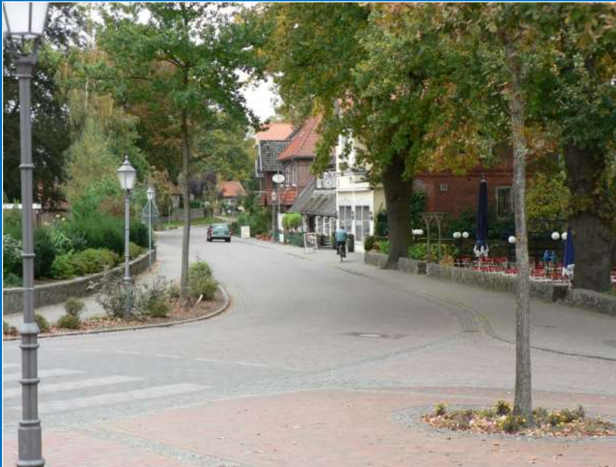
Neugestaltung Kirchvorplatz und Landesstraße
